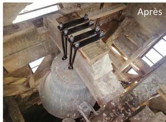
Le mercredi 17 février, une première étape dans la rénovation de l'intérieur de l'église a été réalisée avec le remplacement des brides qui maintiennent la cloche n°2. Une cale en chêne a été également posée pour rectifier la hauteur du mouton.
